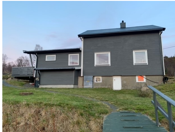
Figur 2-4: Servicebygg sett fra øst
