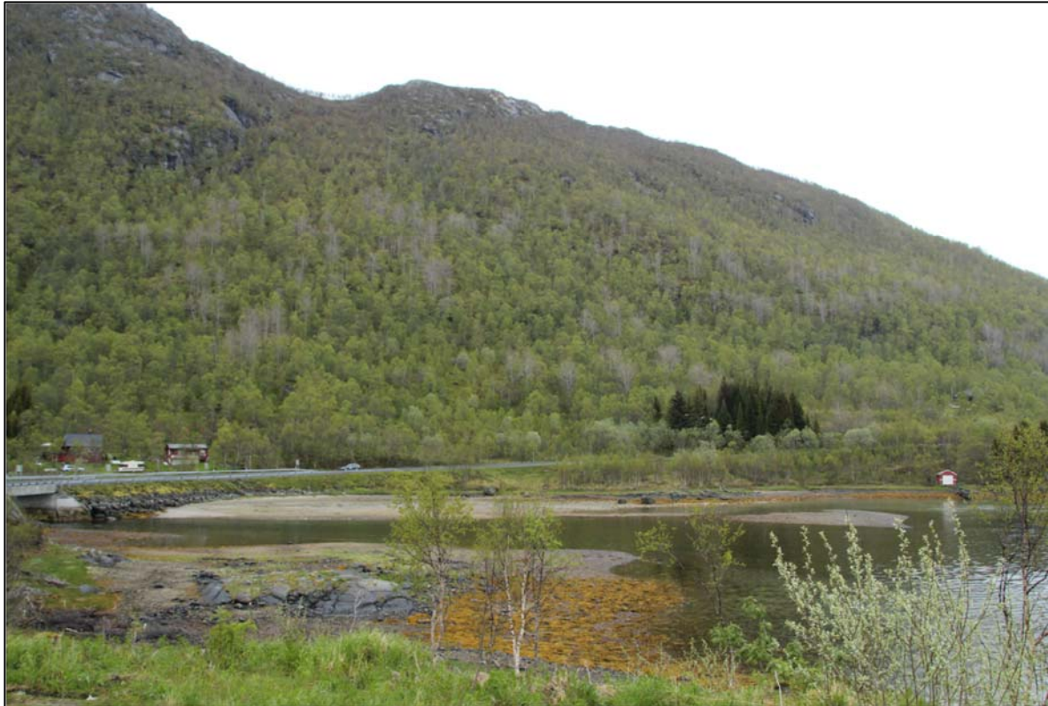
Figur 21: Rv. 85 er planlagt lagt om i tunnel med søndre påhugg G i fjellsiden nord for Løbergsbukt, med noe fare for skred fra Brattfjellet/Kobberryggen opptil 460 moh (foto: Ole-André Helgaas).
