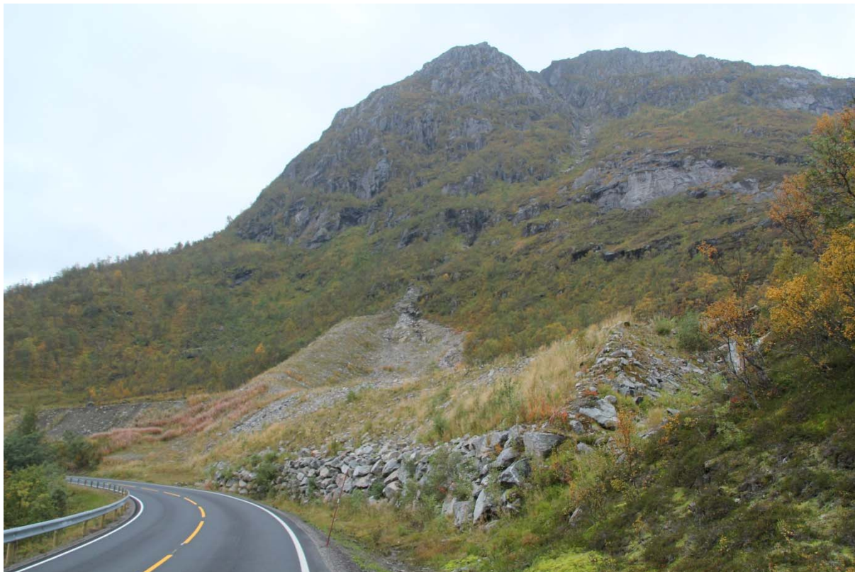
Figur: Rv. 85 i Løbergsbukt/Raksebukt er i dag godt sikret med skredvoller mot snøskred fra fjellet Karitinden. Ny veg planlegges her lagt ut på sjøfylling, noe som gir enda høyere sikringsnivå (foto 17.09.2014: Ole-André Helgaas).
