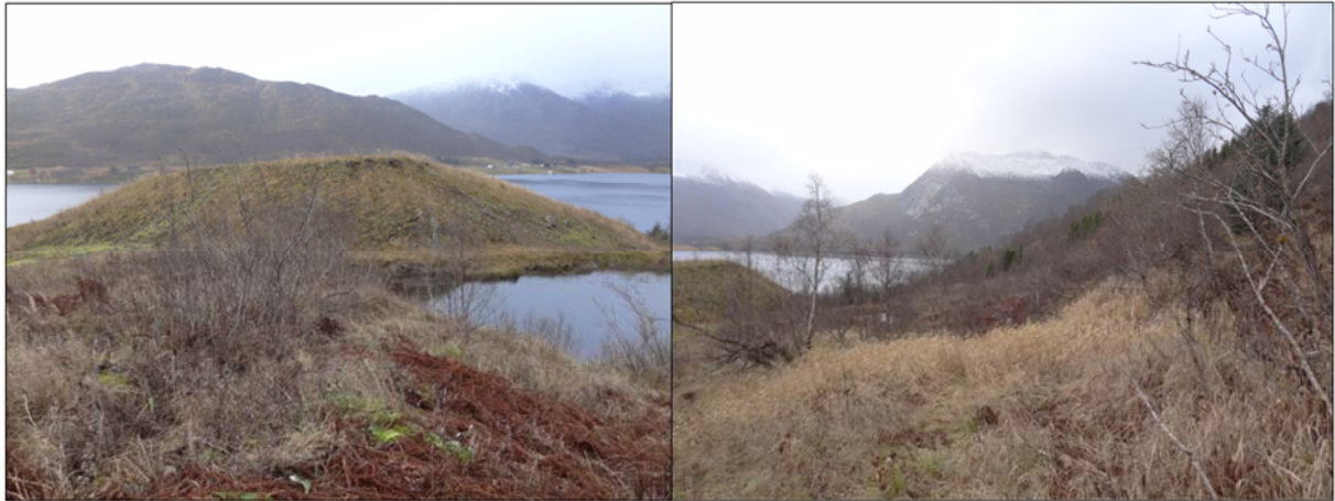
Figur 29: Omr. 3E Lille Våtvoll, foto øvre side av eksisterende plogvoll med «plunge pool», t.h. tydelig spor av skredaktivitet (Foto okt. 2016: O. A. Helgaas).
