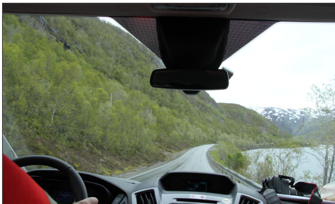
Figur 23: Omr. 3C: Rv. 85 er i dag skredutsatt langs steile fjellsider mellom Våtvoll og Løbergsbukt.
