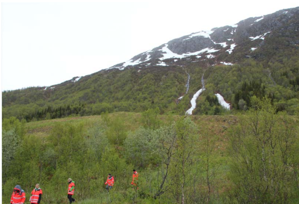
Figur 28: Omr. 3E: Utsikt opp skredområdet under Karitinden som er delvis sikret med plogvoll, flere vårscred vises. Foto tatt på tverrfaglig befaring med prosjektgruppa i Hålogalandsvegen-prosjektet. (Foto 4.6.2015: O. A. Helgaas).
